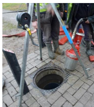
Figuur B1.4. Een open brandput die zo is uitgevoerd dat er door de brandweer van bovenaf een zuigslang of dompelpomp kan worden ingehangen. Linksboven: werktekening. Rechtsboven: werktekening, detail bronkop. Linksonder en rechtsonder: voorbeelden van een gerealiseerde put.
